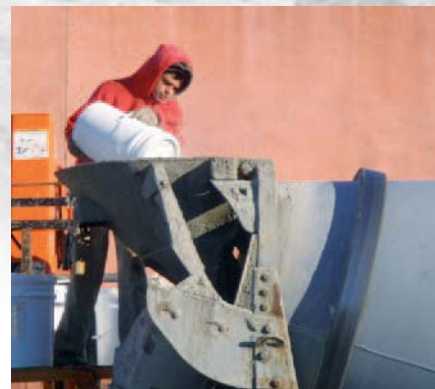
Введение добавки на строительной площадке.
